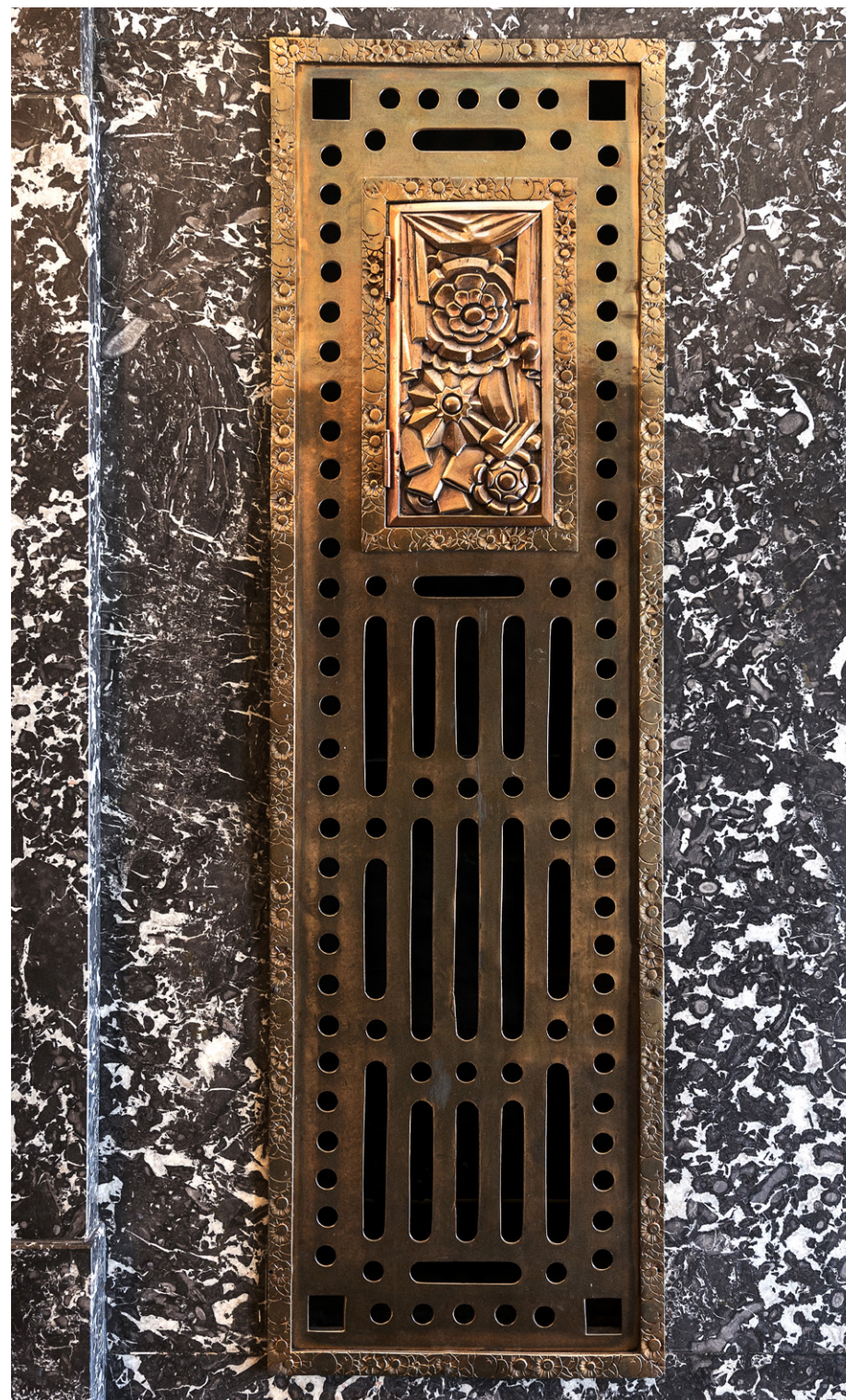
Rooster van de radiatorombouw van de inkomhal.
