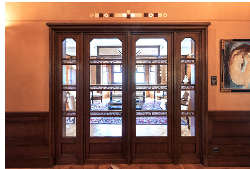
Dubbele deur die toegang verleent tot een van de slaapkamers op de eerste verdieping. De deuren zijn versierd met horizontale glas-in-loodlijsten beschilderd met bloemenmotieven. De deurhendels aan de woon- en halzijde zijn opzettelijk verschillend, om ze te laten passen in het decor.
